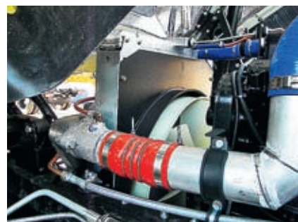
Металлическую часть воздуховода сваривают по обходной технологии
